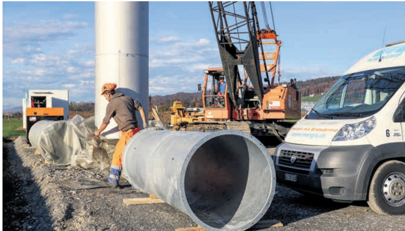
Das neue Grundwasserpumpwerk der Wasserversorgung Hitzkirch, hier beim Bau im November 2018, ging erst im vergangenen Juni in Betrieb. Nun wurden auch hier Höchstwerte überschritten. Foto Archiv SB
